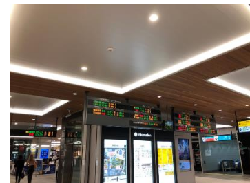
照明設備 LED化
