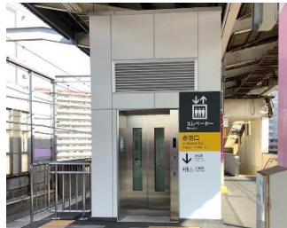
駅改良・駅設備(エレベーター等)
