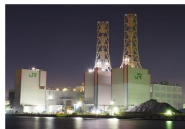
発電所設備更新(川崎火力発電所)
