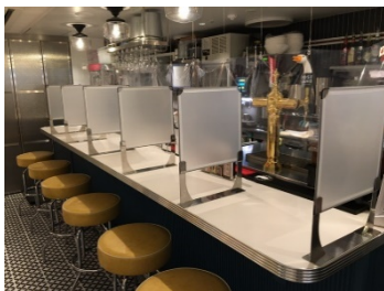
飲食店内の間仕切り設置
