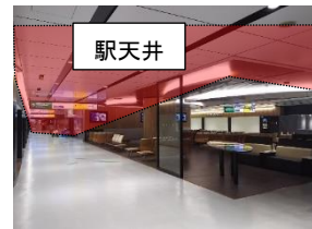
駅舎天井耐震補強
