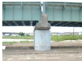
橋脚耐震補強 (コンクリート巻き立て)
