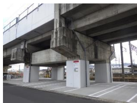
高架橋柱耐震補強 (鋼板巻き補強)
