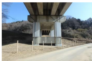
高架橋柱耐震補強 (鋼板巻き補強)
