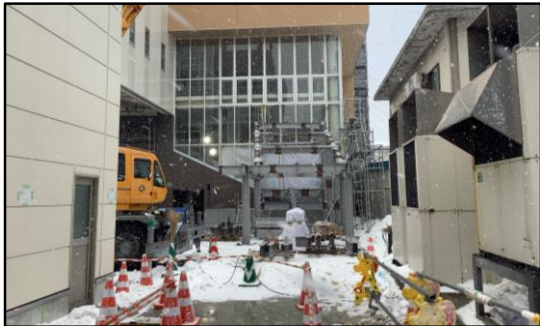
①東口仮通路付近
