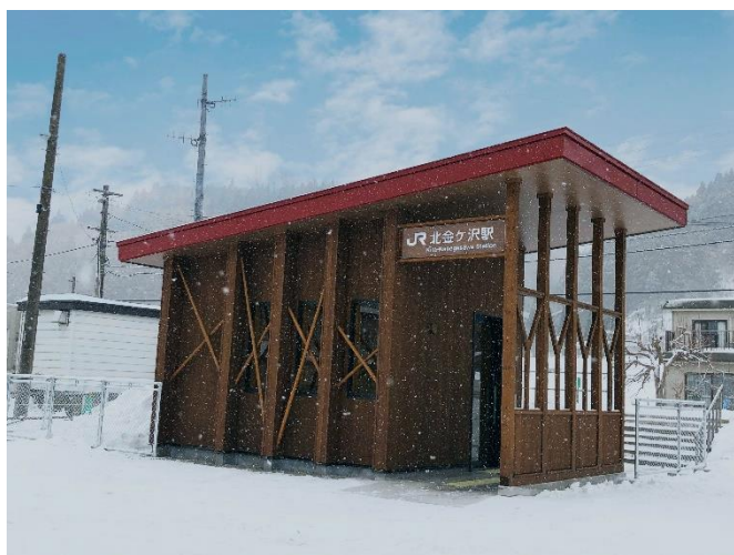
【新駅舎 駅広場側】
