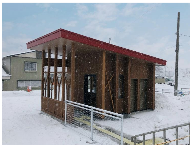
【新駅舎 ホーム側】
