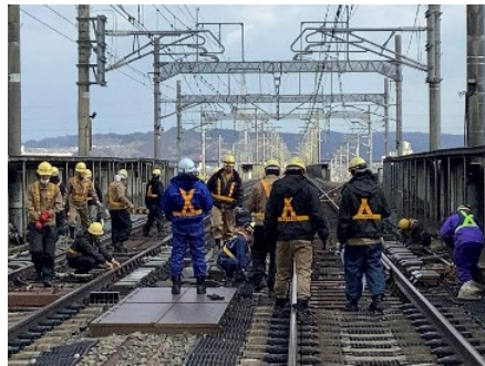
仙台～古川間 分岐器軌道整備
