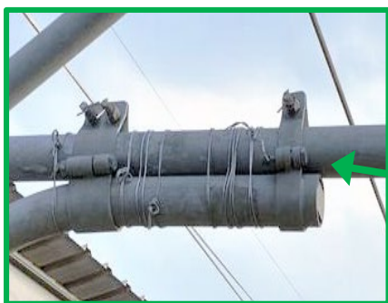
架線金具類の仮復旧箇所
