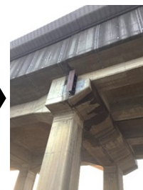
福島～白石蔵王間 高架橋サイドブロック損傷
