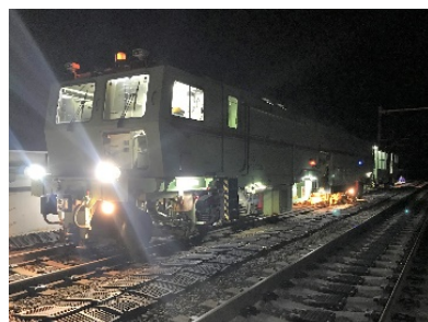
白石蔵王～仙台間 MTT施工
