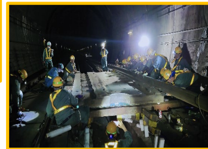
軌道の高低差整備
