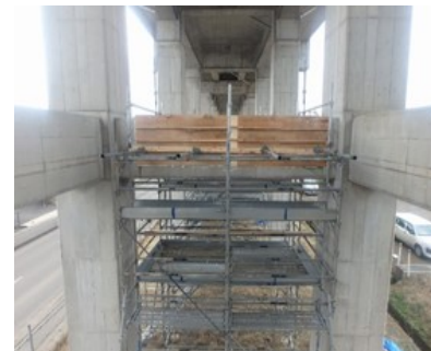
福島～白石蔵王間 高架橋中層梁損傷
