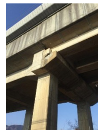
福島～白石蔵王間 高架橋サイドブロック損傷
