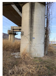
福島～白石蔵王間 高架橋柱損傷
