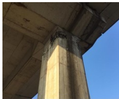
福島～白石蔵王間 高架橋柱損傷
