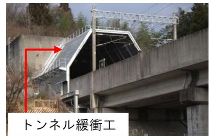
※1 列車通過時の騒音を抑制する工事。一部は新たに基礎を設置のうえ、かさ上げを行います。
