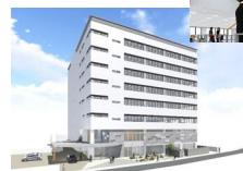
支社ビル整備
