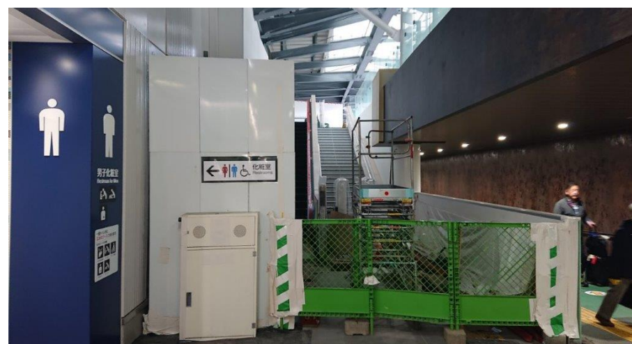
工事期間中のコンコースの仮囲い設置状況
