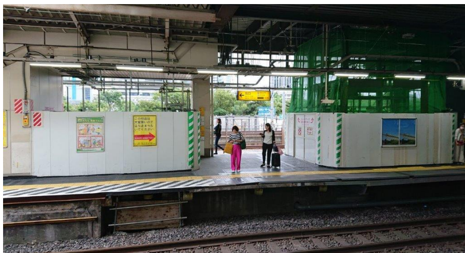
工事期間中のホーム上の仮囲い設置状況
