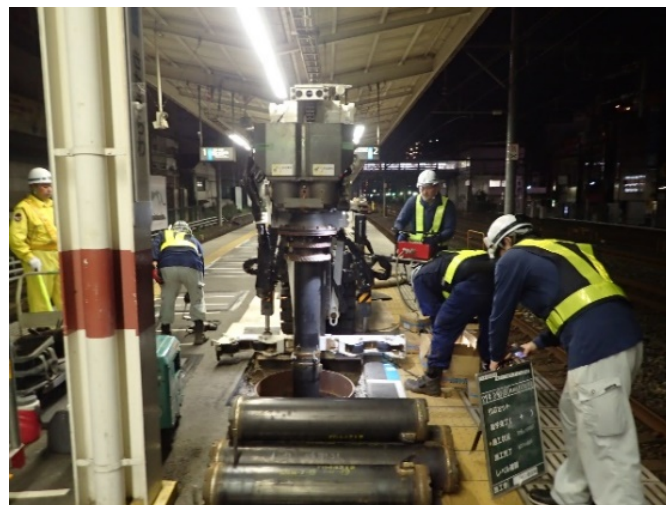
ホームドアの基礎工事（杭打ち作業）
