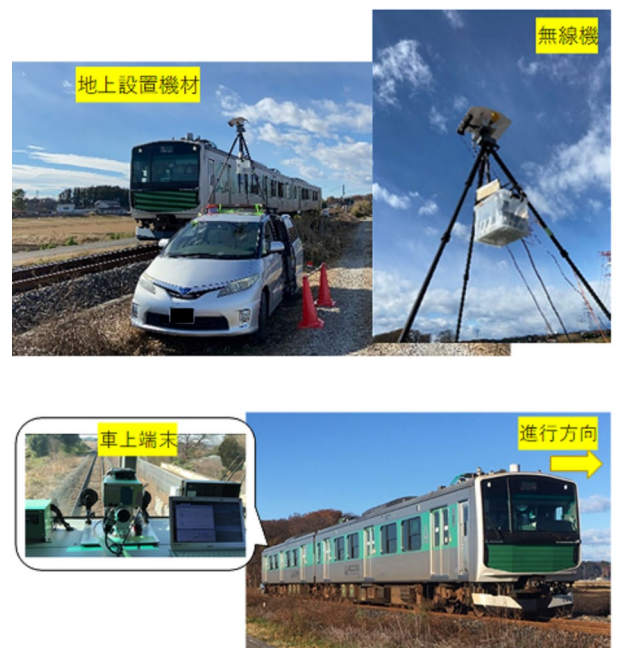
図1 実証実験での無線機設置の様子(上:地上、下:車上)
