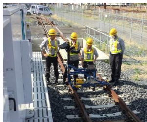
トラックマスターの取扱い訓練
