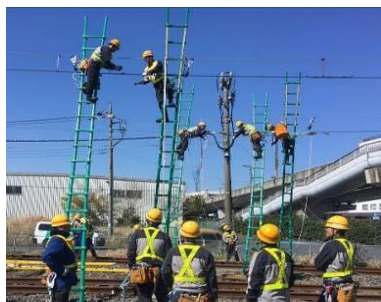
架線の取替訓練 (電力)
