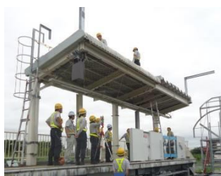
旅客上家の点検訓練
