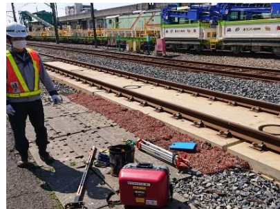
新幹線のスラブ軌道の測定訓練 (保線)
