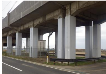
ラーメン高架橋耐震補強事例 (鋼板巻き補強)
