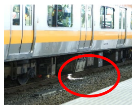
線路設備モニタリング装置
