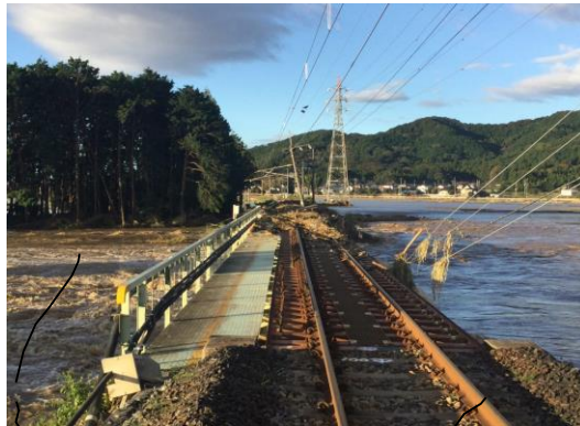
③両毛線 大平下～栃木間 永野川橋りょう 橋台背面流出
