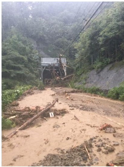
②中央本線 梁川～四方津間 土砂流入
