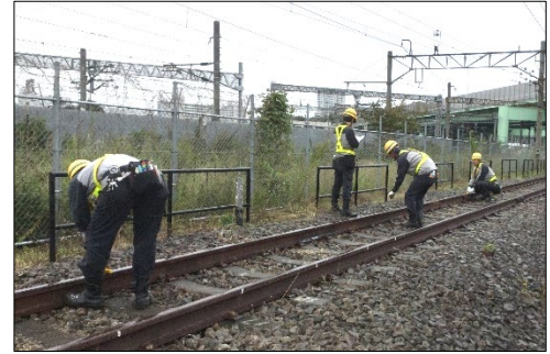
【線路での検査業務の様子】
