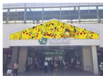
屋外ガラス壁面
