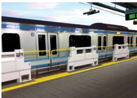
ホームドア(スマートホームドア®)
