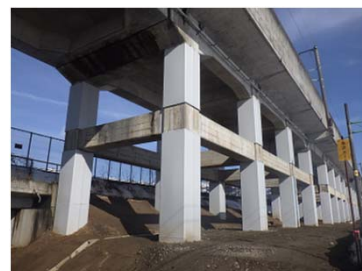
高架橋耐震補強
