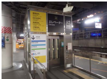
エレベーター
