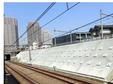
盛土耐震補強
