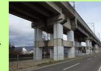
更なる耐震補強の対象エリアの設備(例) 橋脚・橋桁が一体的構造のラーメン高架橋 盛土
