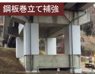
高架橋柱(新幹線)
