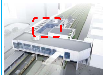
(駅舎屋上) 太陽光パネル設置
