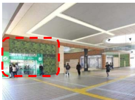
(自由通路) 自然素材活用、壁面緑化
