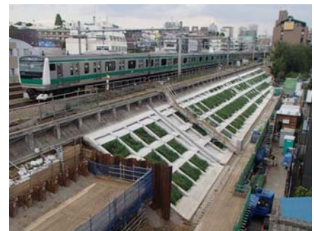
完了写真(高田馬場駅～目白駅間)
