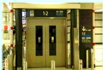
成田空港駅エレベーター増設
