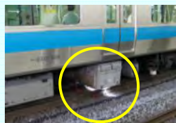
線路設備モニタリング
