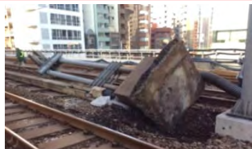
山手線神田～秋葉原間電化柱倒壊
