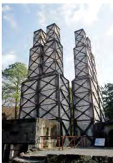
「反射炉」とは、大砲を作るために鉄を溶かす炉のことで、炉の内部の天井に炎と熱を反射させて高い温度を作りだしたことからこの名がつけられました。大砲製造時には反射炉の周囲に当時の日本としては最先端技術を持った製砲工場がありました。
