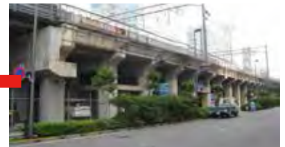
現況写真（開発前）
