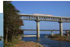
三陸鉄道・安家川橋梁
