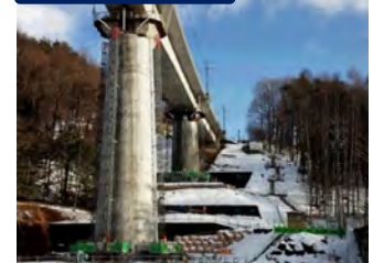
橋脚耐震(在来線)
