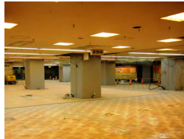
高架下利用箇所(店舗)
