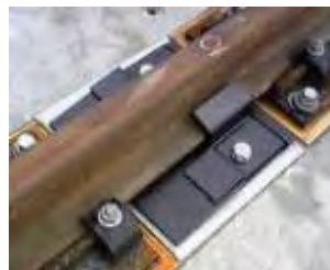
新幹線レール転倒防止装置
