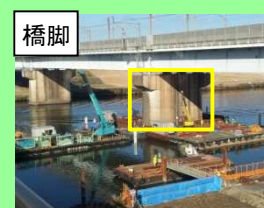
橋脚 東北新幹線 上野～大宮間
