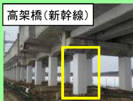
高架橋(新幹線) 東北新幹線 水沢江刺～盛岡間
