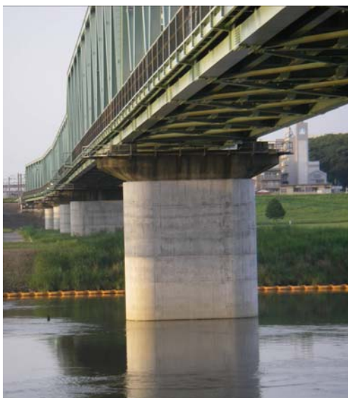
橋脚耐震補強
