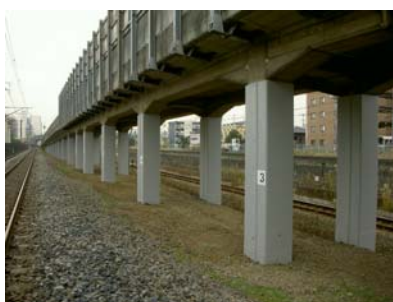
高架橋柱耐震補強
