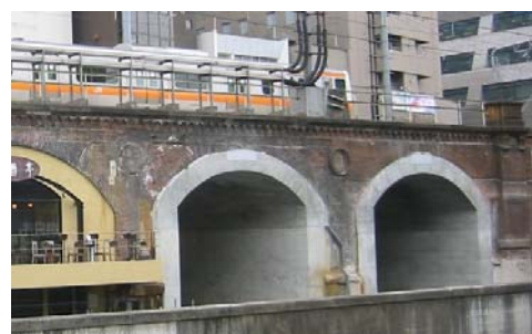
レンガアーチ耐震補強
