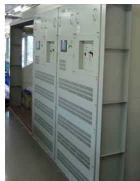
蓄電池座席下移設 (4ユニット中の1ユニット)
