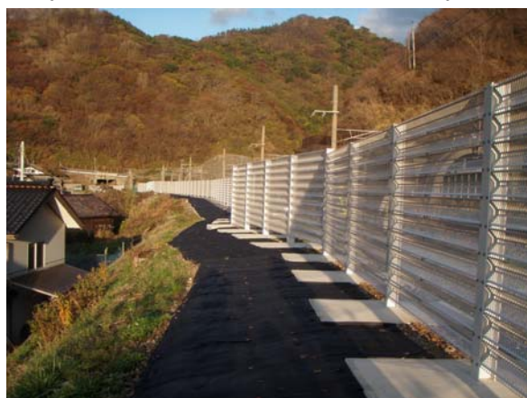
【図2】完成した防風柵 （羽越本線 あつみ温泉～小波渡間）
