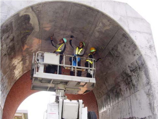
トンネル検査訓練（土木）
