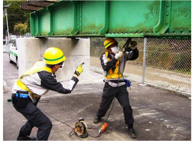
橋りょうひずみ測定訓練（土木）
