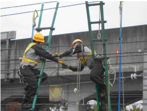
架線断線復旧訓練（電力）
