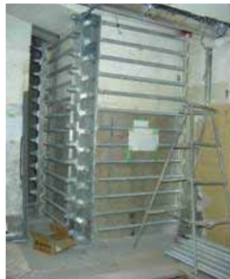
リブバー補強工法
