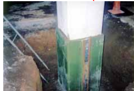
(土の中も補強)
