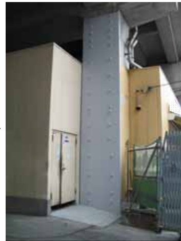
( 施工後 ( 一面補強工法 ) )
