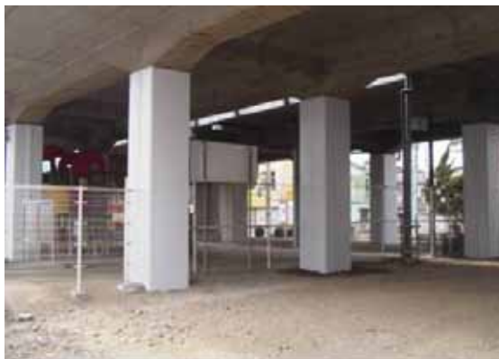
鋼板巻き工法(施工後)
