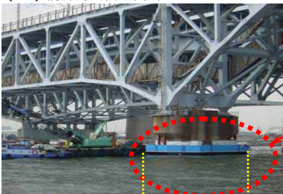
鋼製函体を用いた鉄筋コンクリート巻き立て補強 ( 補強箇所が水中部にある箇所 )
