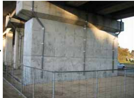
( 施工後 ( 鉄筋コンクリート巻き立て補強 ) )
