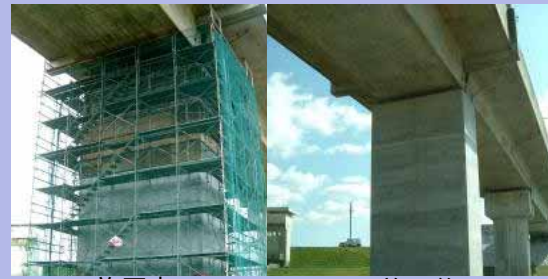
[施工中] [施工後] 自然災害対策(地震対策)
