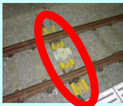
防護管敷設(約1,400箇所)
