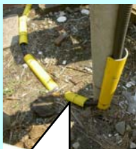
誤切断防止カバー取付(約31,500箇所)
