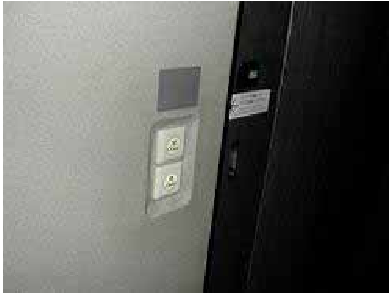
開閉ボタン(車椅子対応トイレ)
