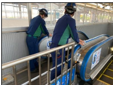
エスカレーター手摺ベルト
