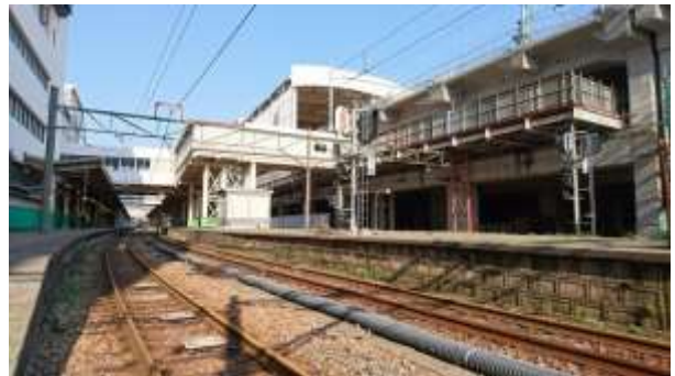
旧 1 番線・2 番線の線路の一部
