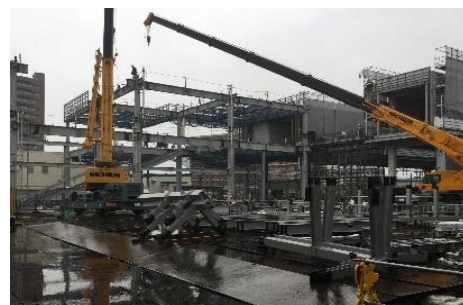
【青森駅自由通路工事等の現場】
