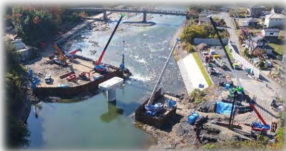
現場施工状況
