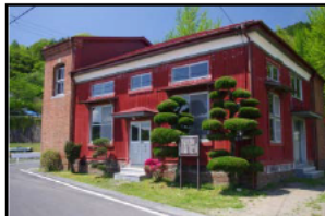
【旧町屋変電所】
