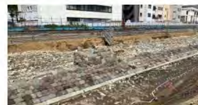
信号機土台の様子
