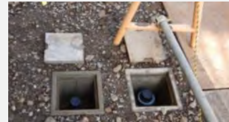
観測井戸の新設
