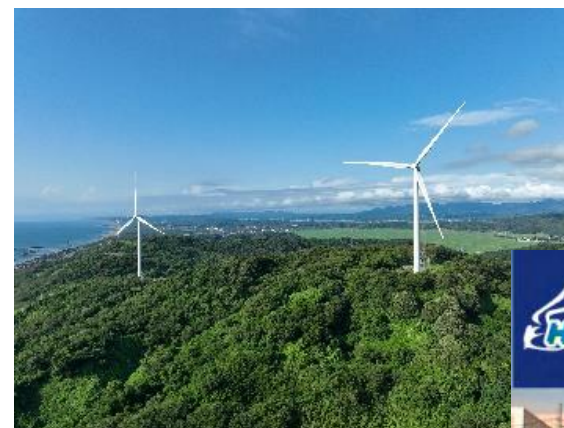
西目西ノ沢 風力発電所
