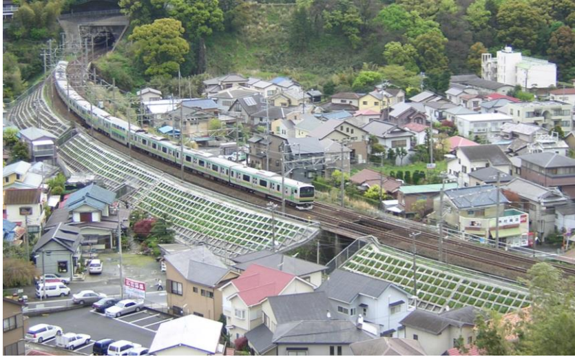
盛土のり面の防災対策
