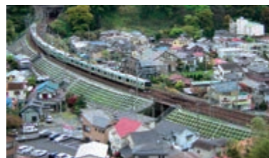
盛土のり面の防災対策
