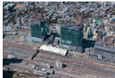
TAKANAWA GATEWAY CITY(建設中)
