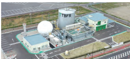
■東北バイオフードリサイクル仙台工場
