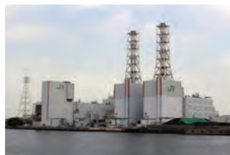
川崎発電所(火力発電所)
