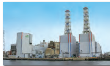
川崎火力発電所
