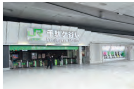
競技会場周辺等の駅改良工事（千駄ヶ谷駅）
