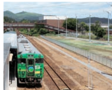
小型風力発電設備（男鹿駅）
