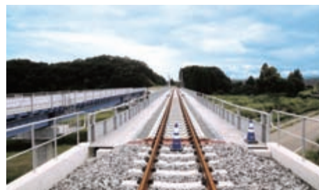
常磐線富岡～浪江間復旧工事
