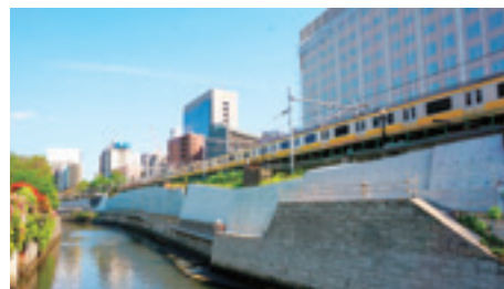
盛土部の耐震補強対策
