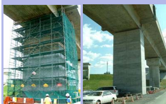
〔施工中〕 〔施工後〕 自然災害対策（地震対策）
